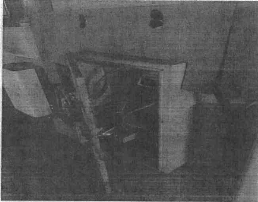
Foto nº 12- Armario boca de incendio con cristal roto
