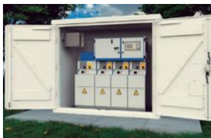
Imagen 11. Centro de seccionamiento tipo
