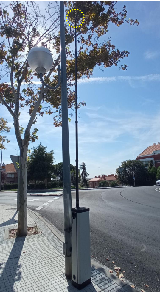
Figura 37. Instalación de cámara de grabación de tráfico, intersección 2.
