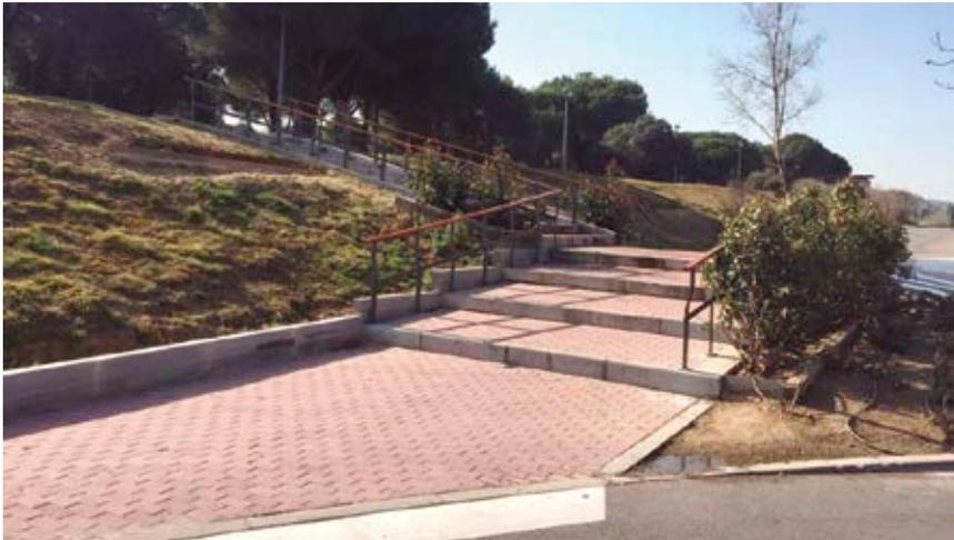
En total se han instalado 54 metros de barandillas, divididos en 6 tramos a ambos lados de las escalinatas. Están compuestas por pilastras de acero galvanizado y pasamanos de madera de pino tratada para la protección contra la radiación ultravioleta y los hongos.
